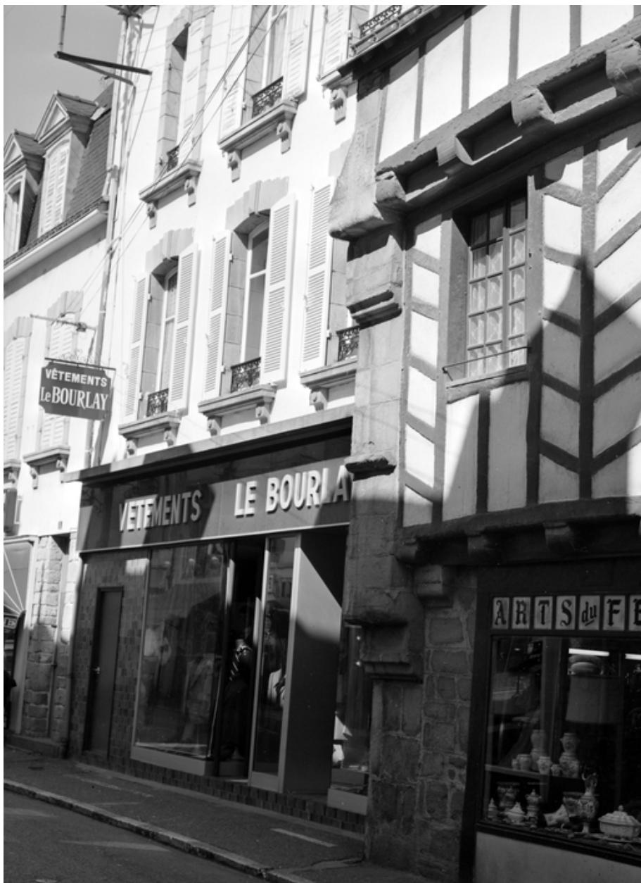
Partie gauche de l'étage en pan de bois, ancré dans un mur à ressauts.
