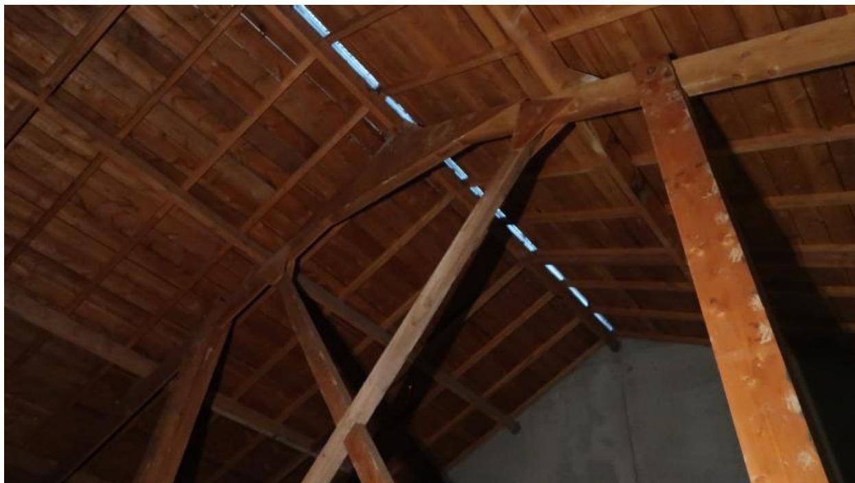
Charpente en bois du bâtiment A.
