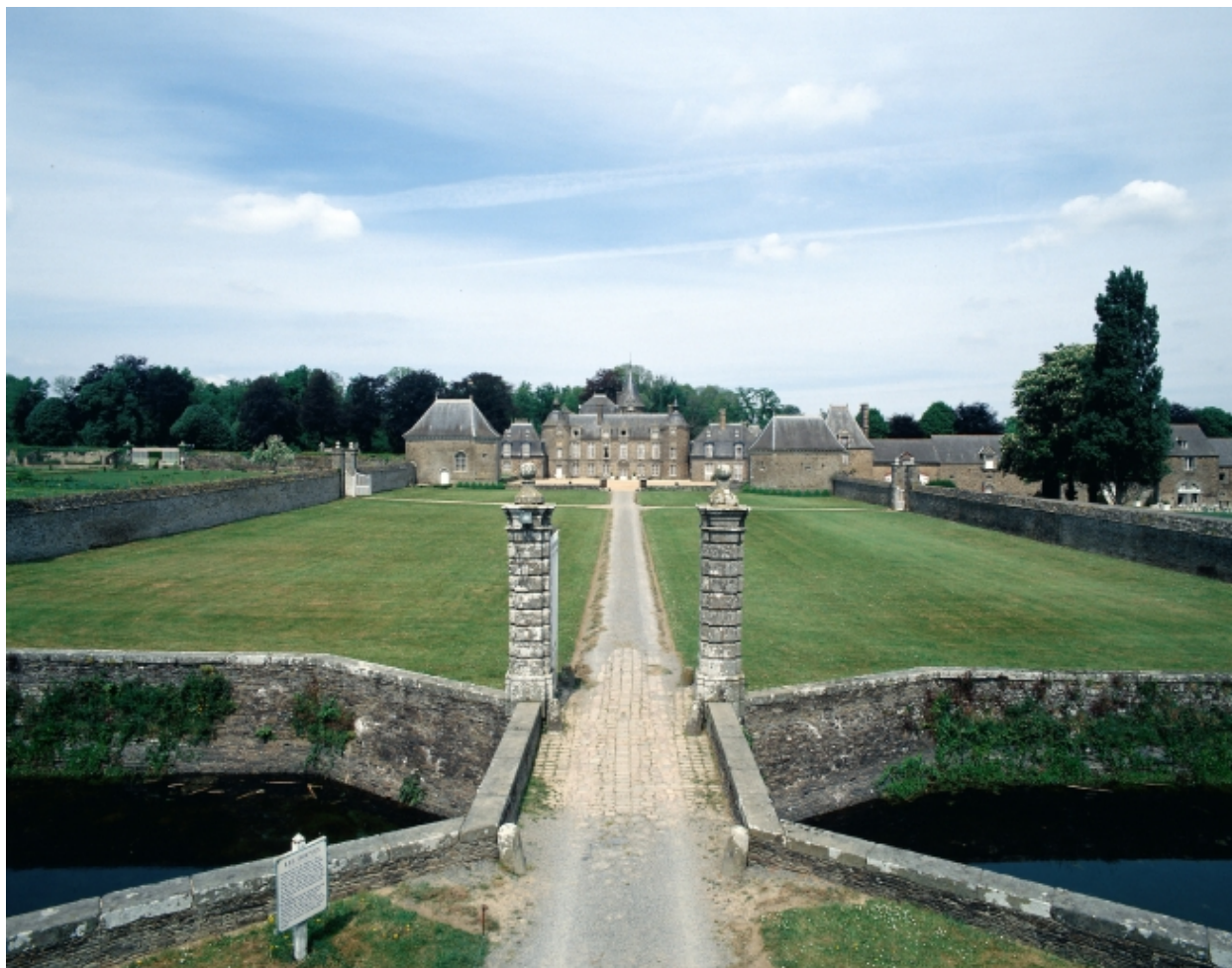
Vue générale sud
