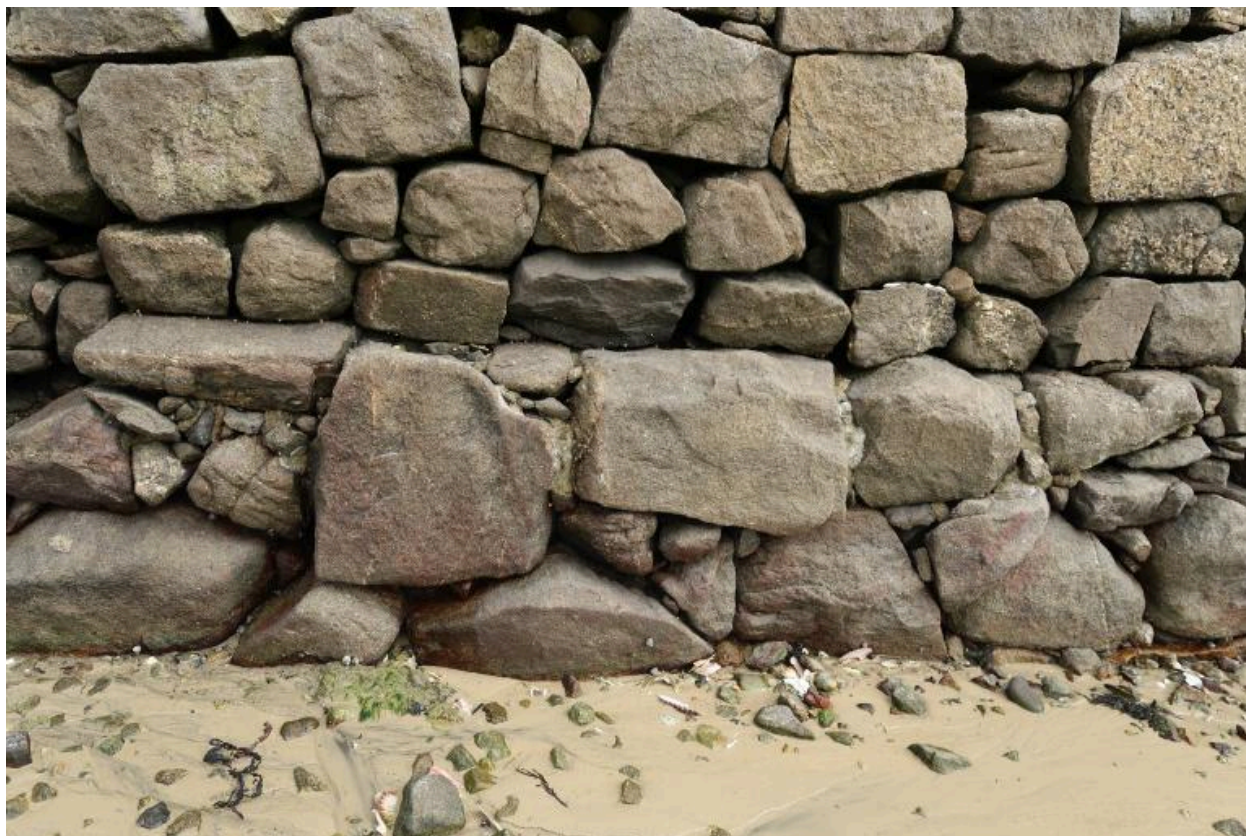
Cale de Porz Kernog, détail de mise en oeuvre en pierres-sèches
