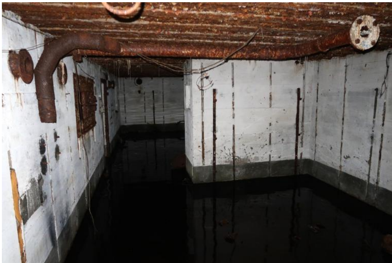
Vue intérieure : salle de garde nord, mur de refend avec les supports muraux pour trois couchettes tubulaires
