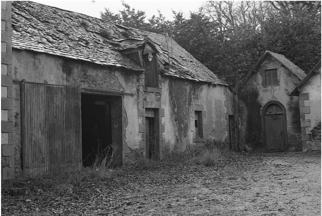
Communs, état en 1979, élévation nord, vue générale
