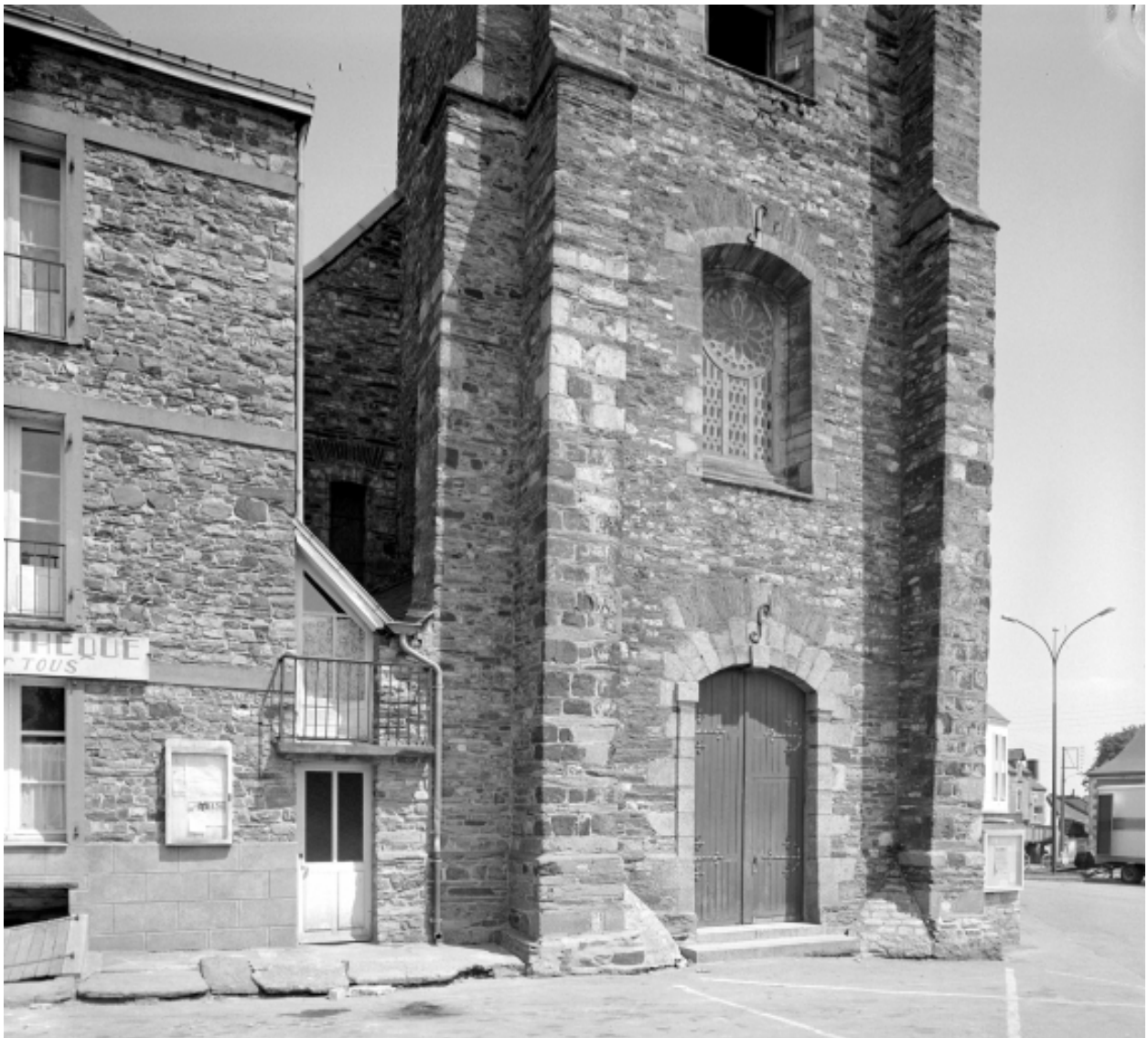
Clocher-porche, niveaux inférieurs.
