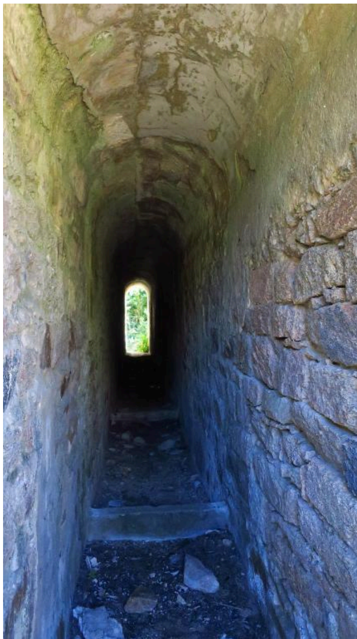
Fort central, Île-d'Houat. Magasin à poudre, gaine latérale ouest
