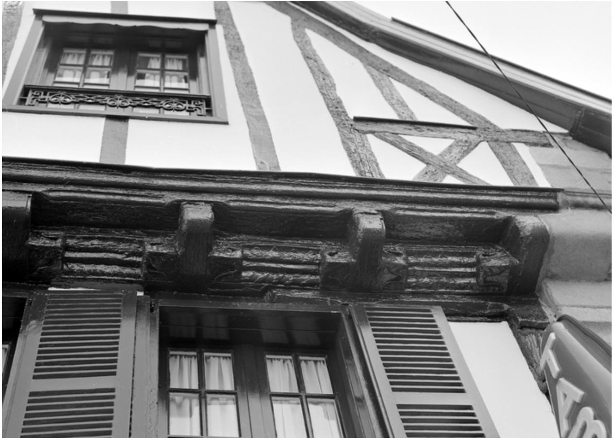
Élévation antérieure, détail de l'encorbellement du 2e niveau : entretoises moulurées
