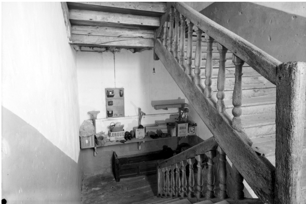
Escalier : vue générale
