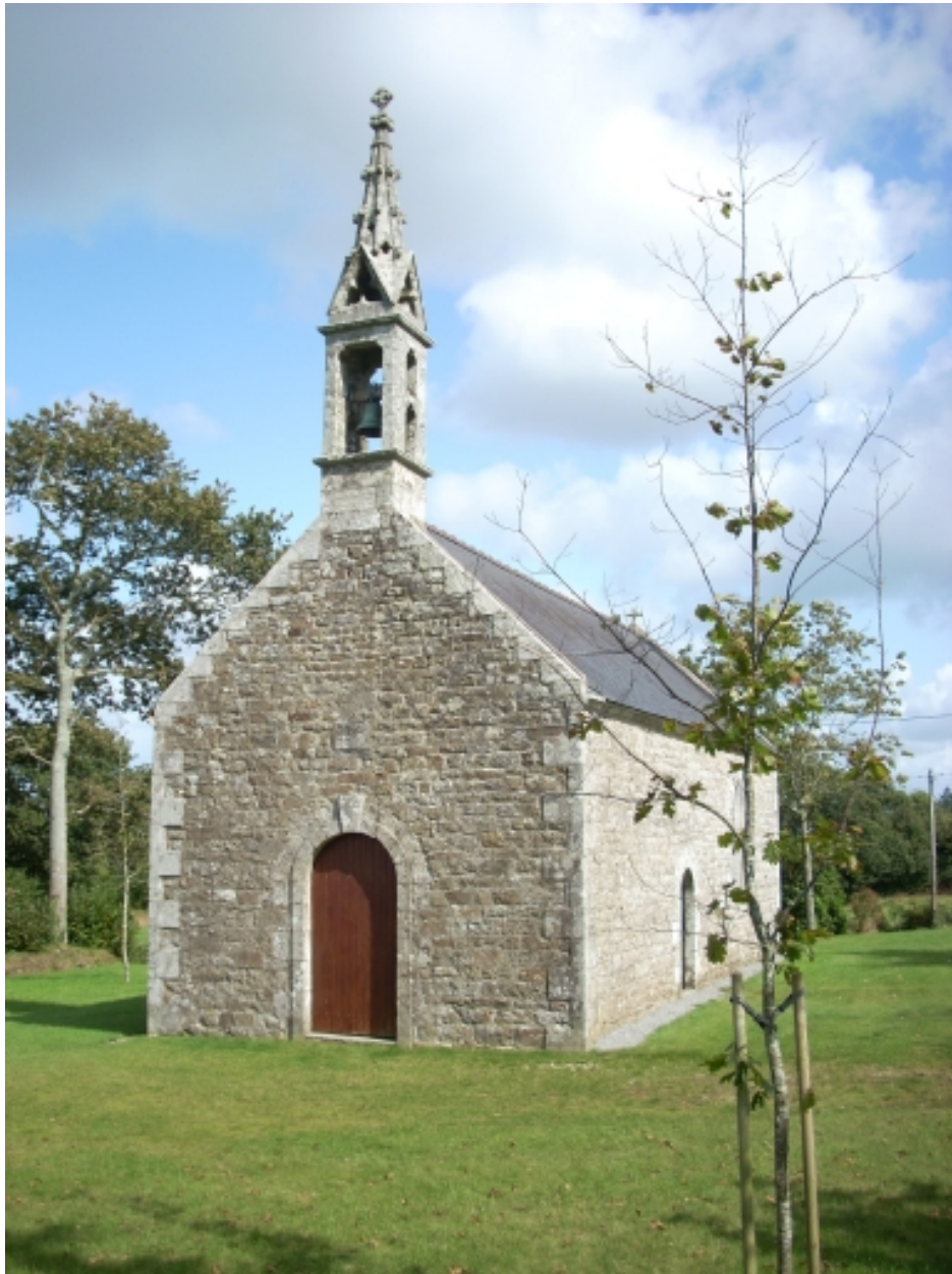
Saint-Evarzec, chapelle Sainte-Véronique : vue générale sud-ouest
