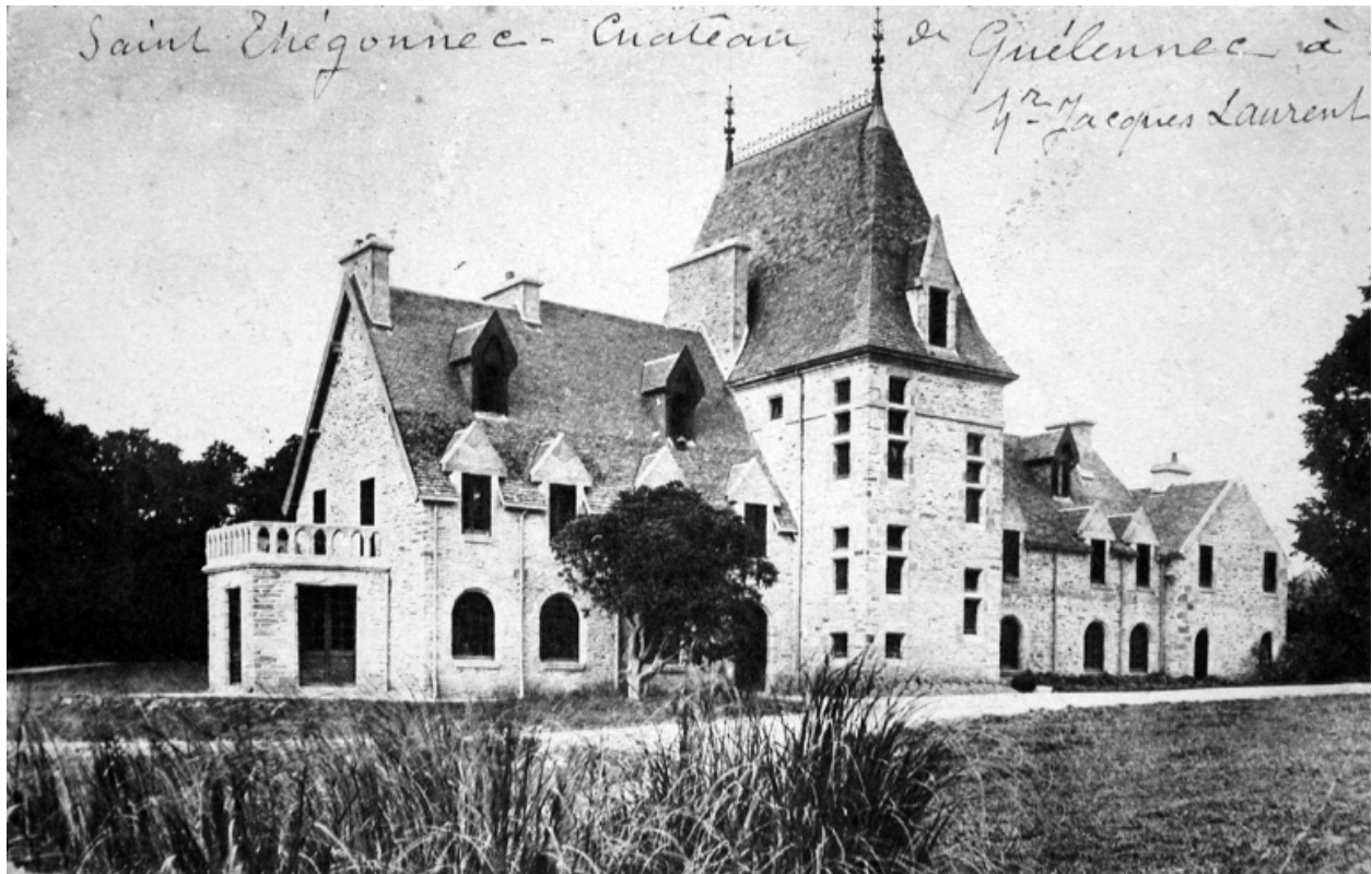
Vue générale de la façade postérieure
