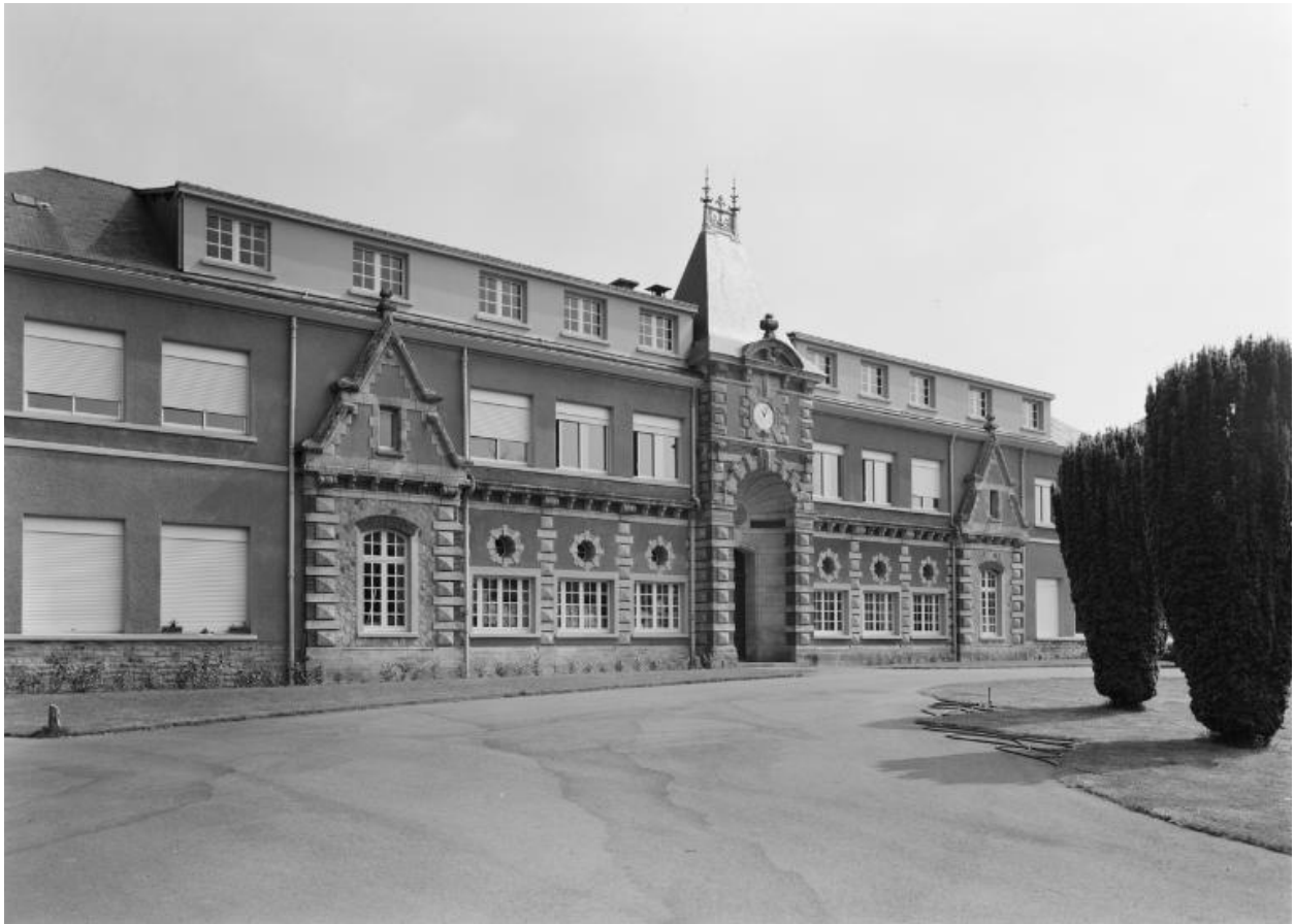
Château, communs, élévation sud.
