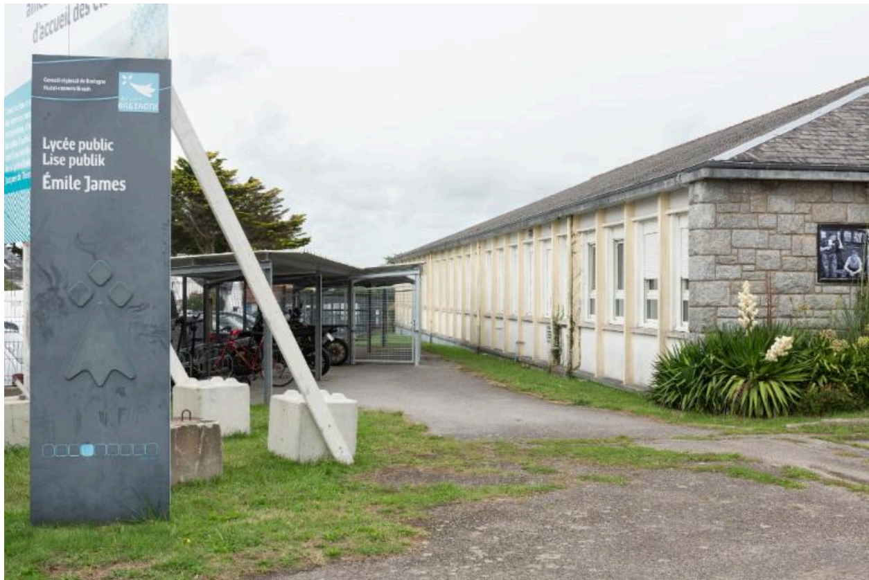
Façade ouest de l'externat (Yves Guillou et Georges Tourry, architectes, 1959) et abri à vélos.
