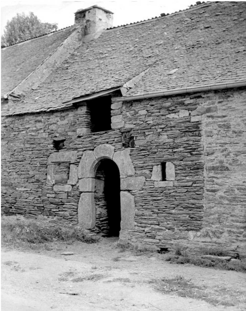
Le Lério : ferme du 17e siècle (état en 1969)
