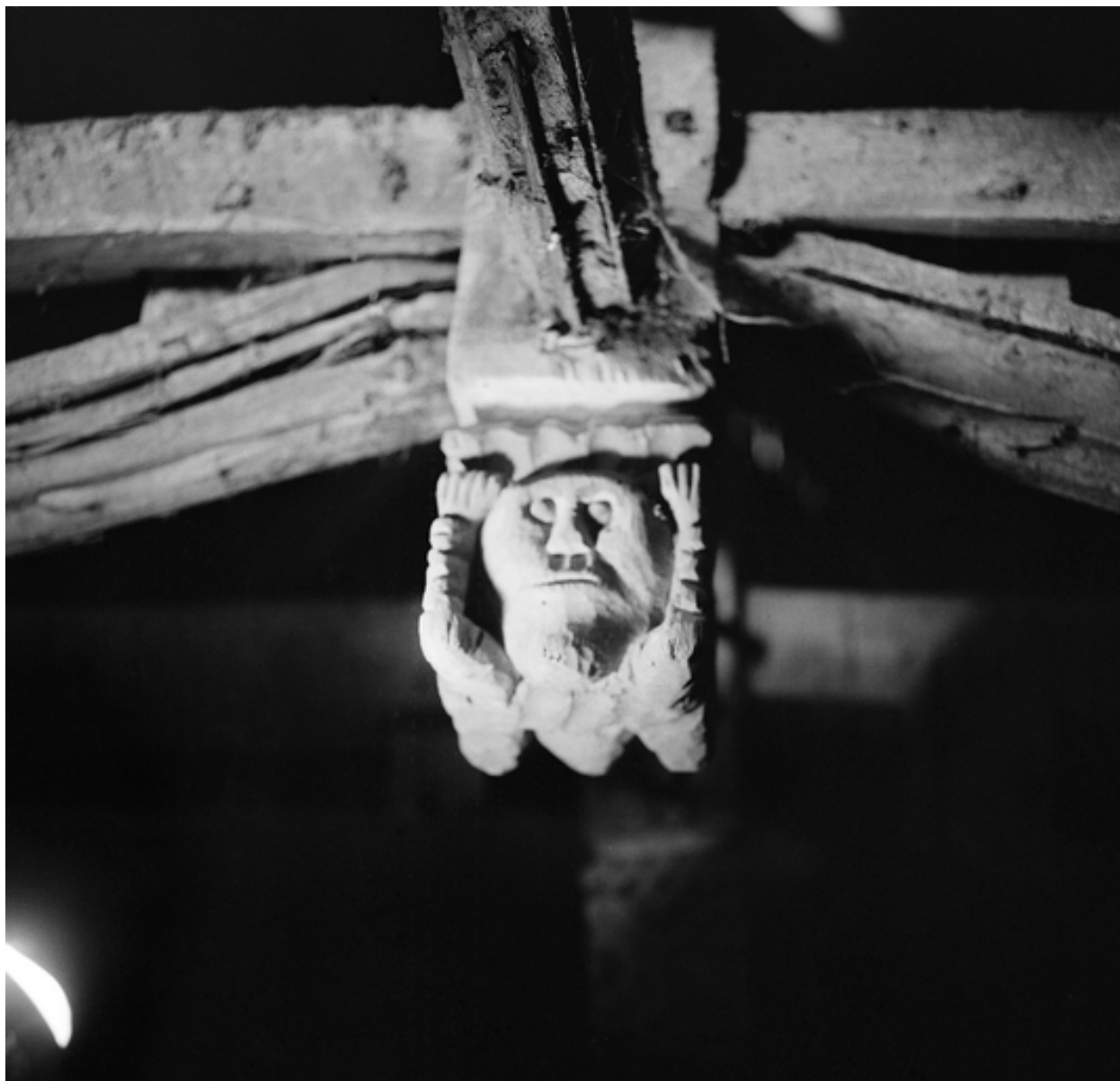
Charpente, détail de la clé 6.
