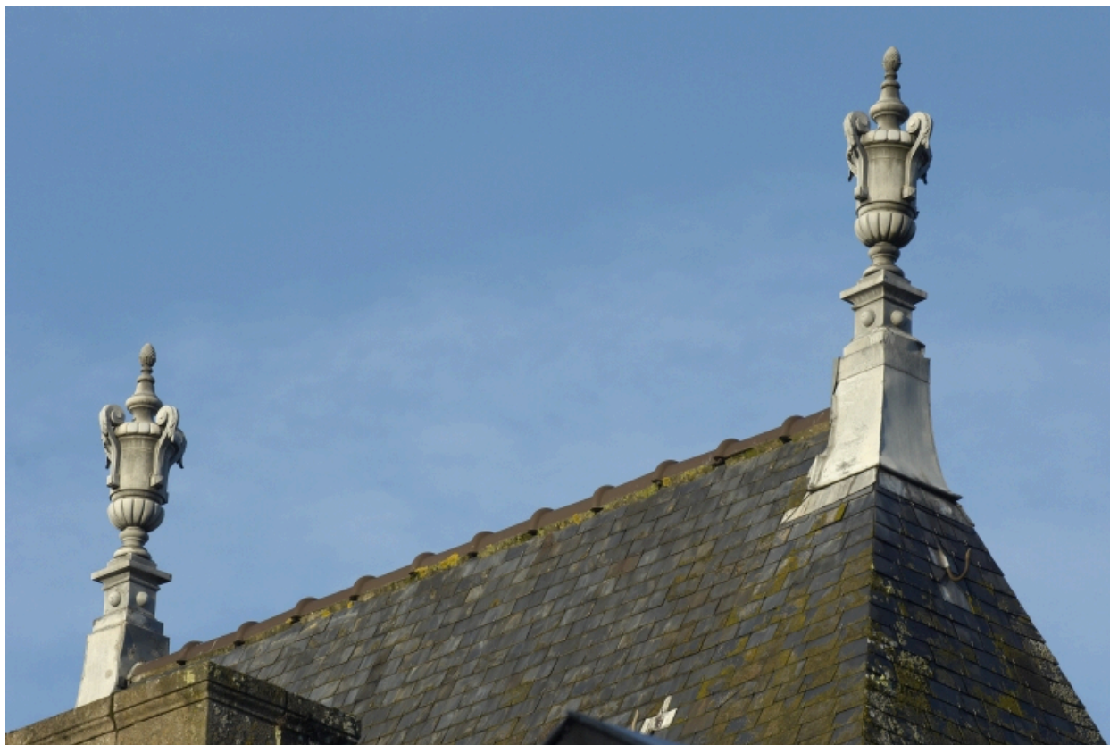
Epis de faîtage du pavillon sud-est
