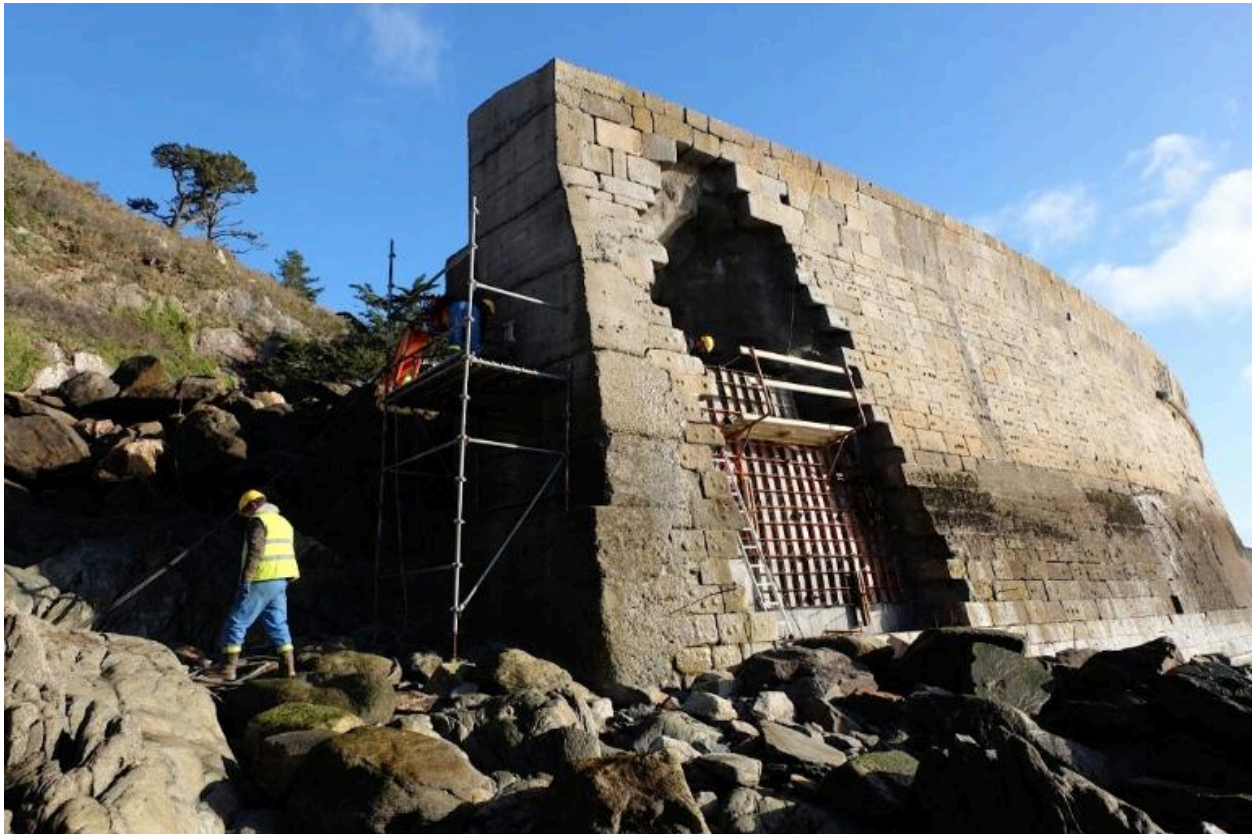
Vue des travaux de consolidation de 2015 : coffrage du mur en béton armé de la brèche de la batterie basse
