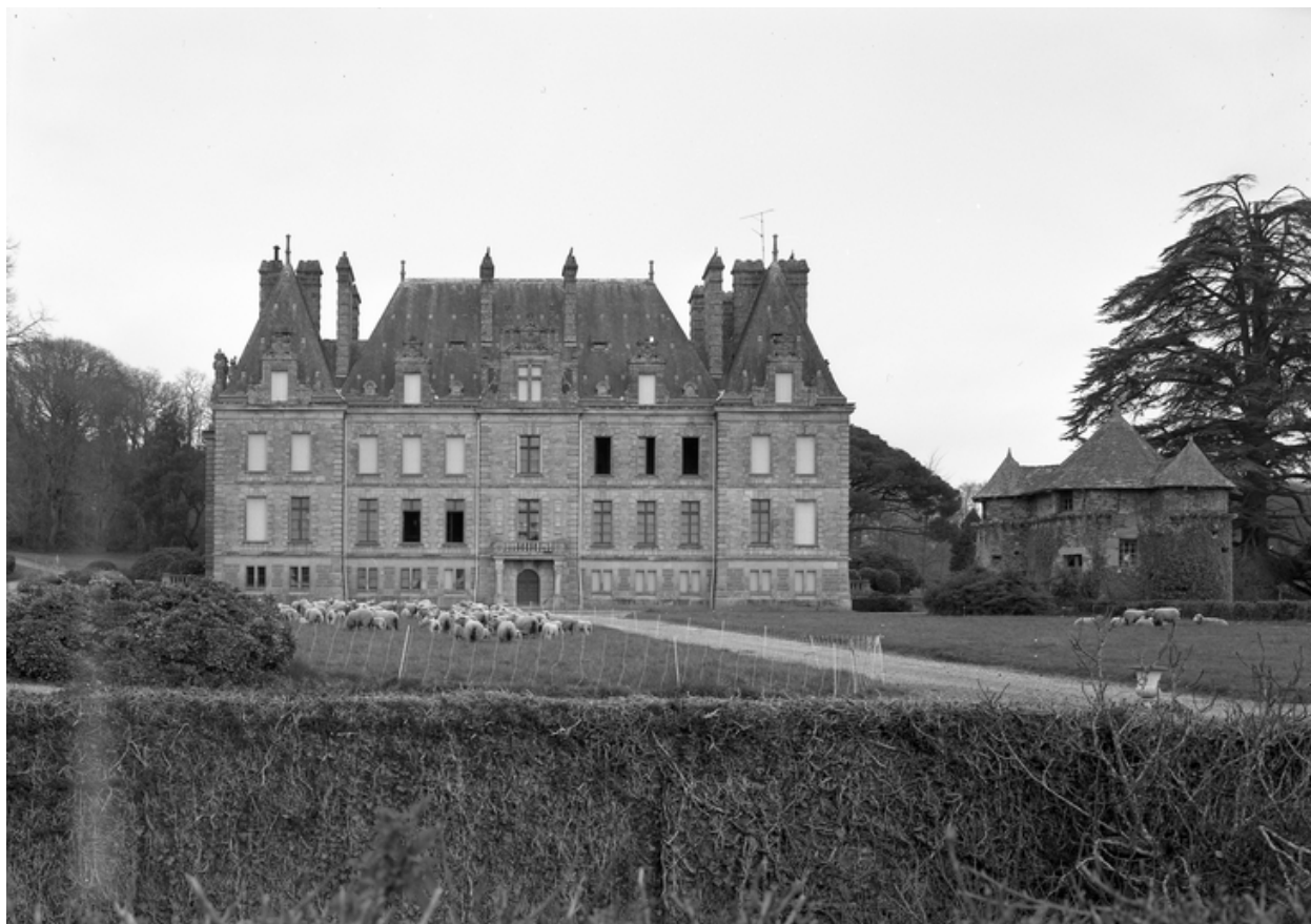
Logis, vue générale sud
