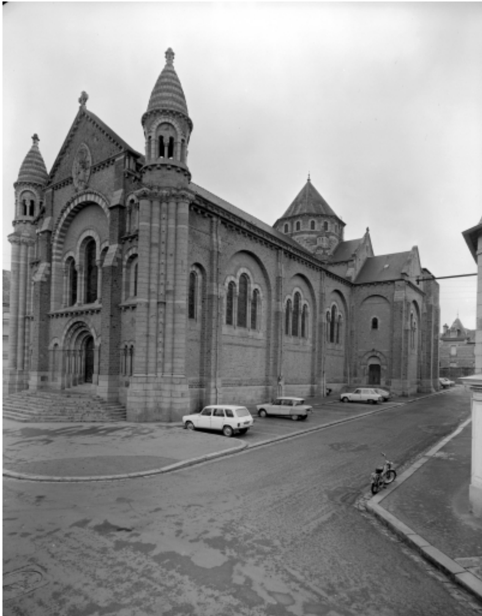
Elévation Sud-Ouest : vue générale.
