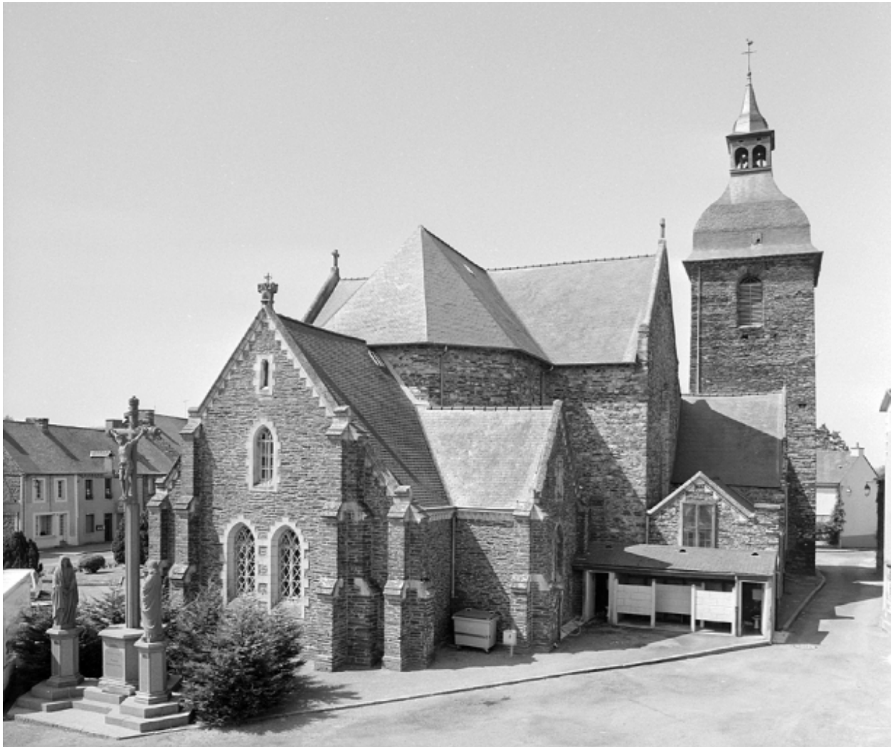
Vue générale est
