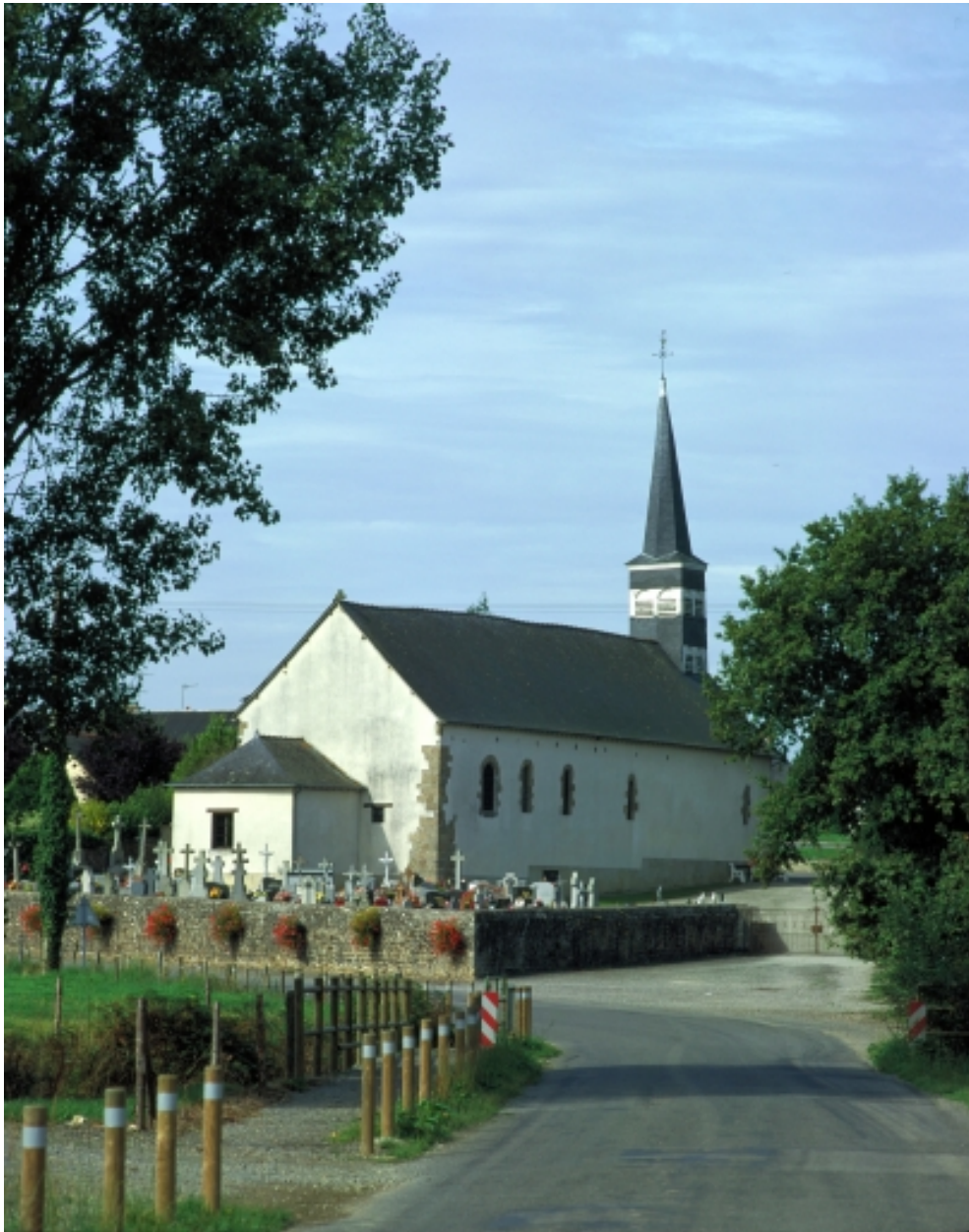
Vue de situation nord-est
