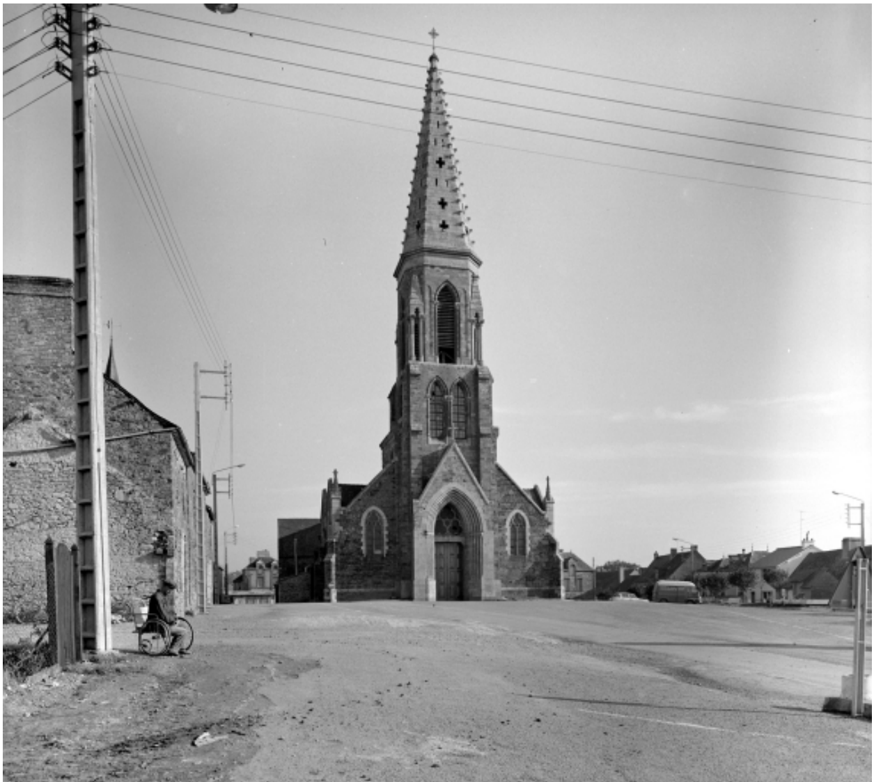
Elévation Ouest : vue générale
