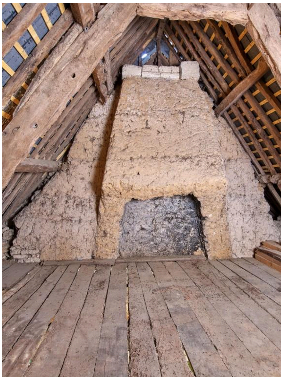
Conduit de la cheminée en terre
