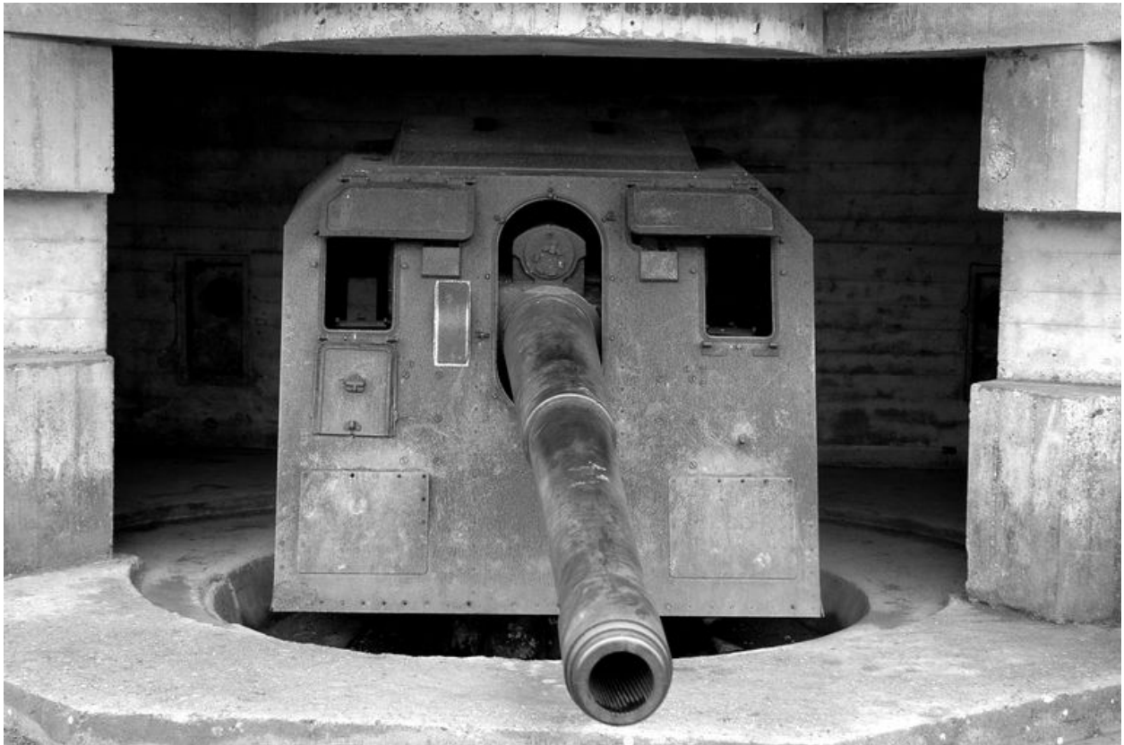
Vue de la tourelle de canon de l'une des quatre casemates de la batterie de Longues-sur-Mer (casemate n° 4 depuis l'est)
