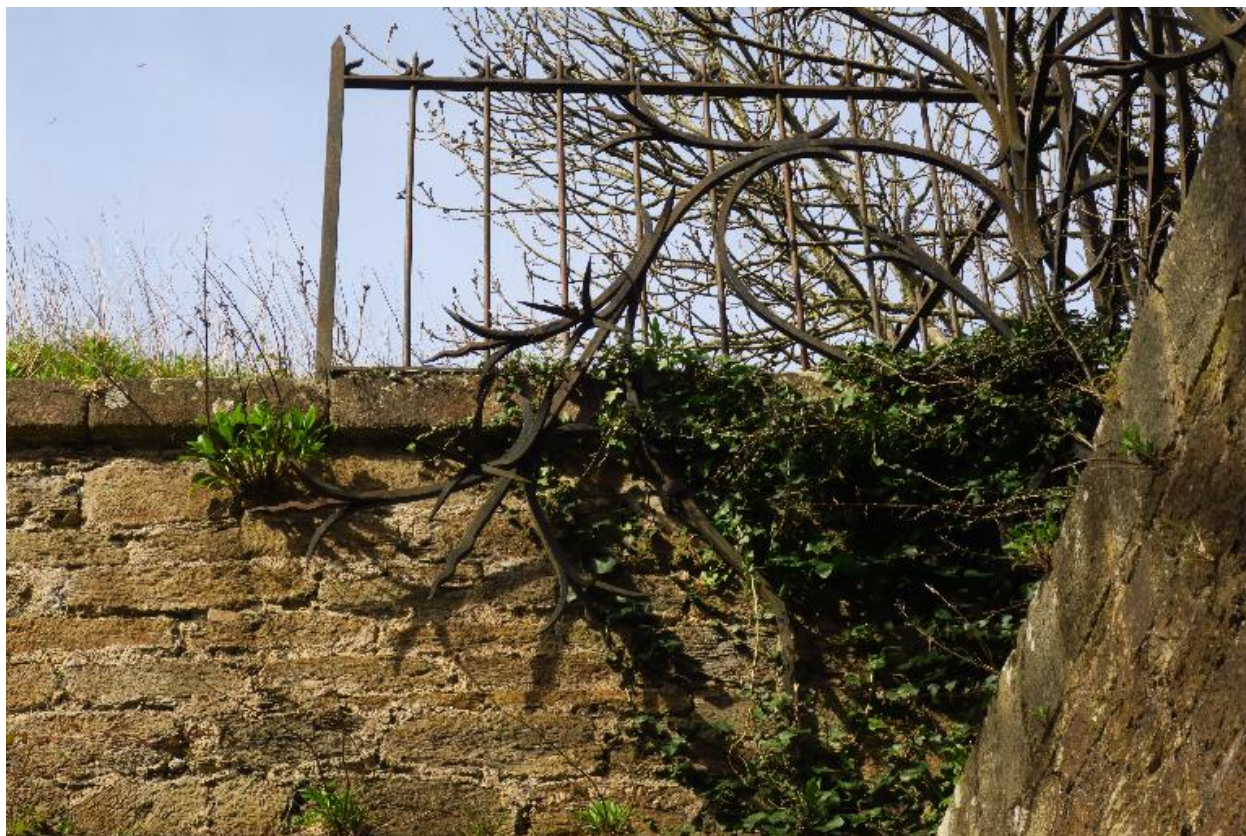
Le Palais, enceinte urbaine, bastion 20, grille défensive.
