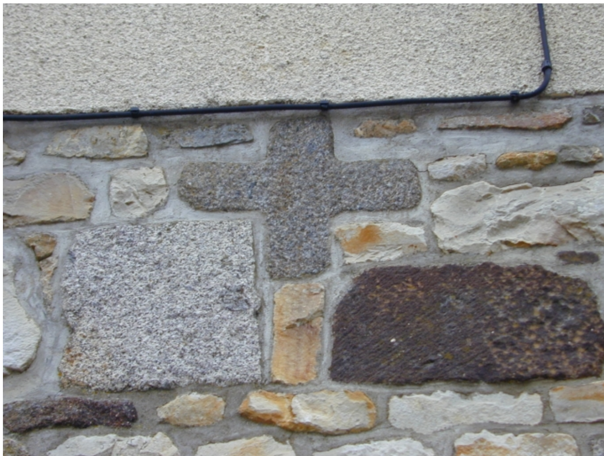
Elévation antérieure : détail du mur
