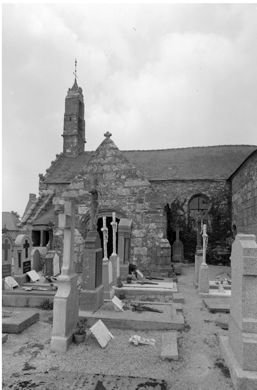
Façade sud : vue générale du porche
