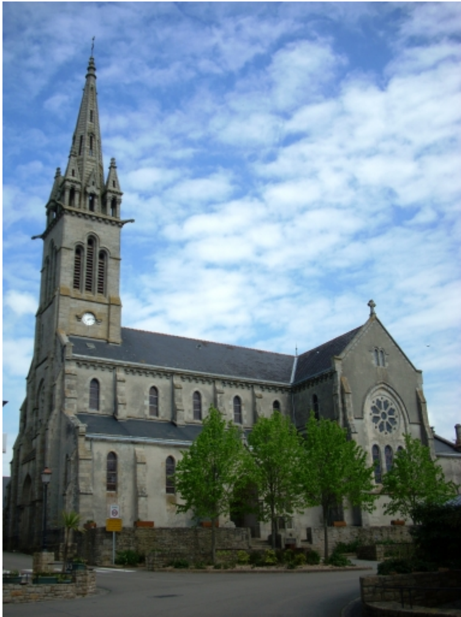
Plogastel-Saint-Germain, église paroissiale Saint-Pierre : vue générale sud-ouest
