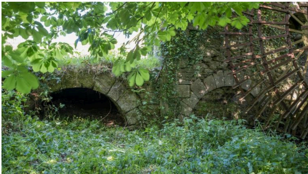
Canaux de fuite voûtés du moulin à papier
