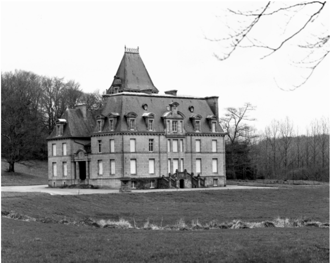
Vue générale, élévation est
