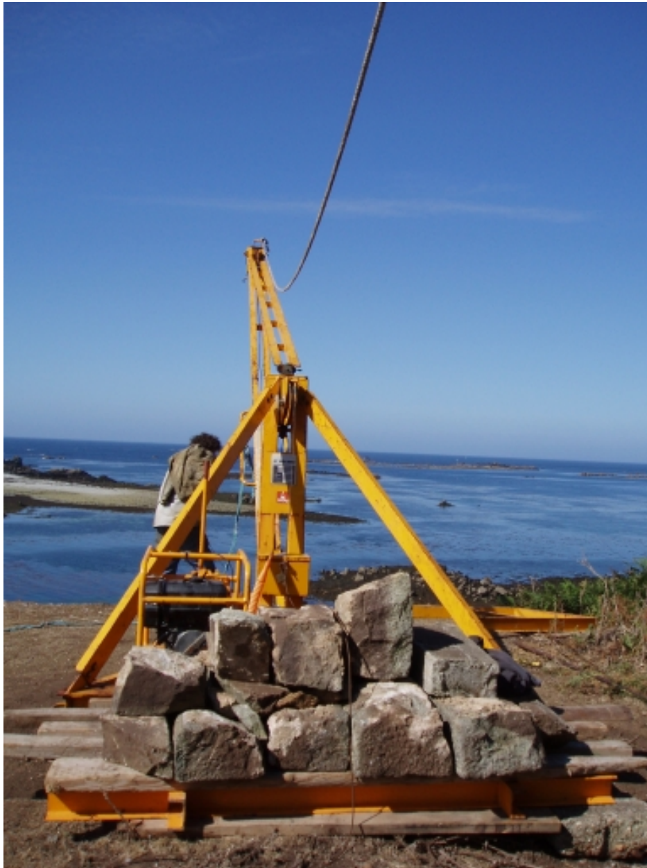
Utilisation d'une grue treuil en aplomb de la falaise (collection particulière)
