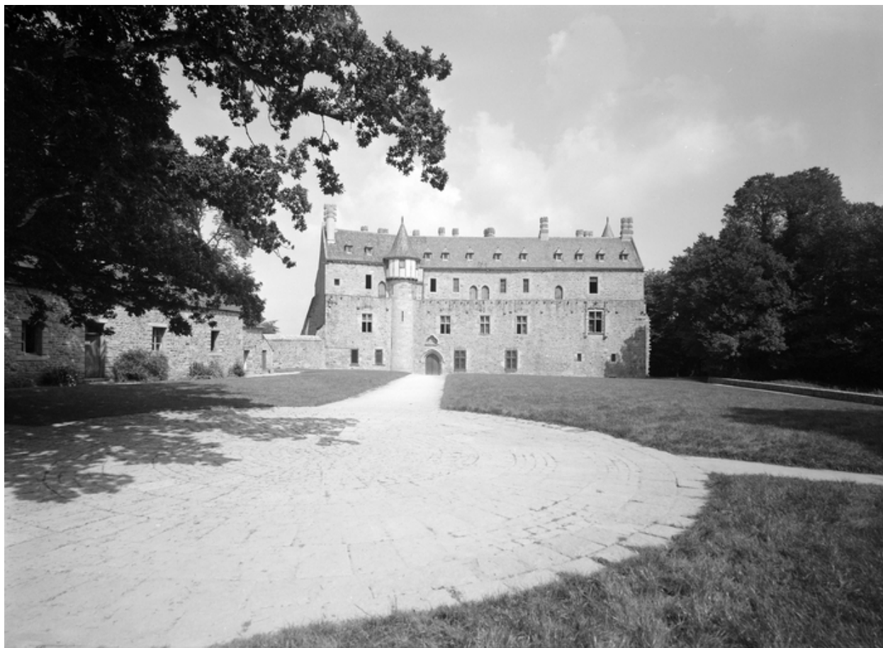
Vue générale depuis le sud-ouest : élévation antérieure (état en 1974)
