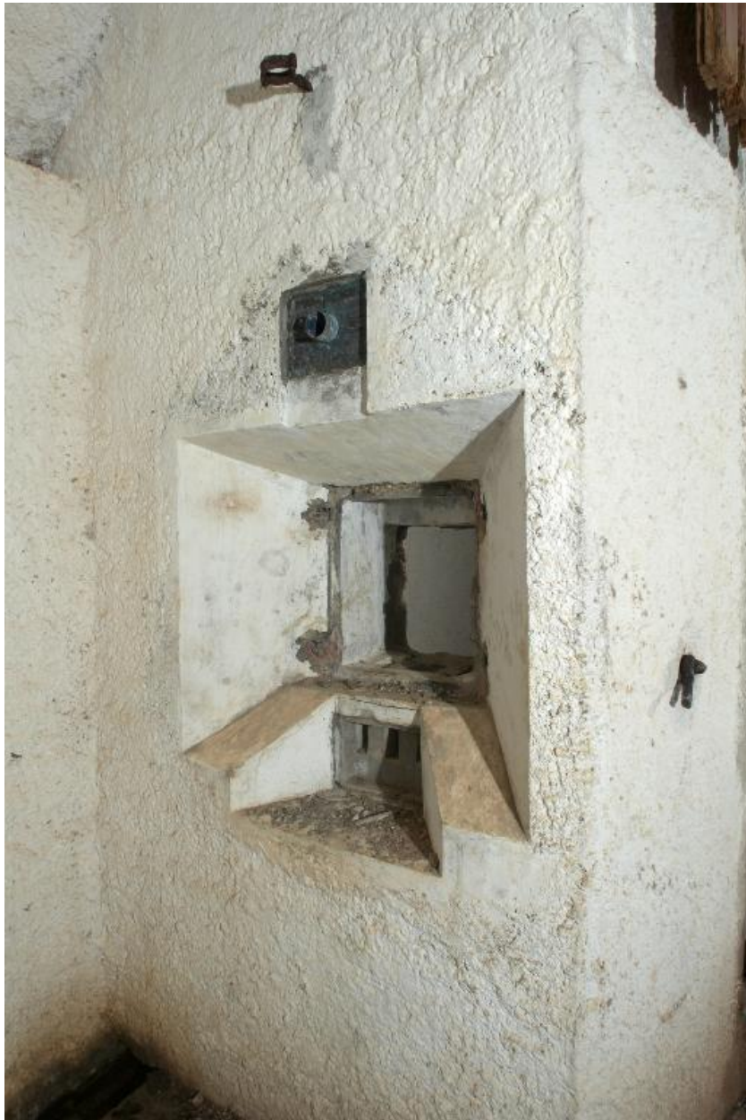
Camaret, pointe du Toulinguet : magasin à poudre sous roc (construction vers 1892), créneau à lampe
