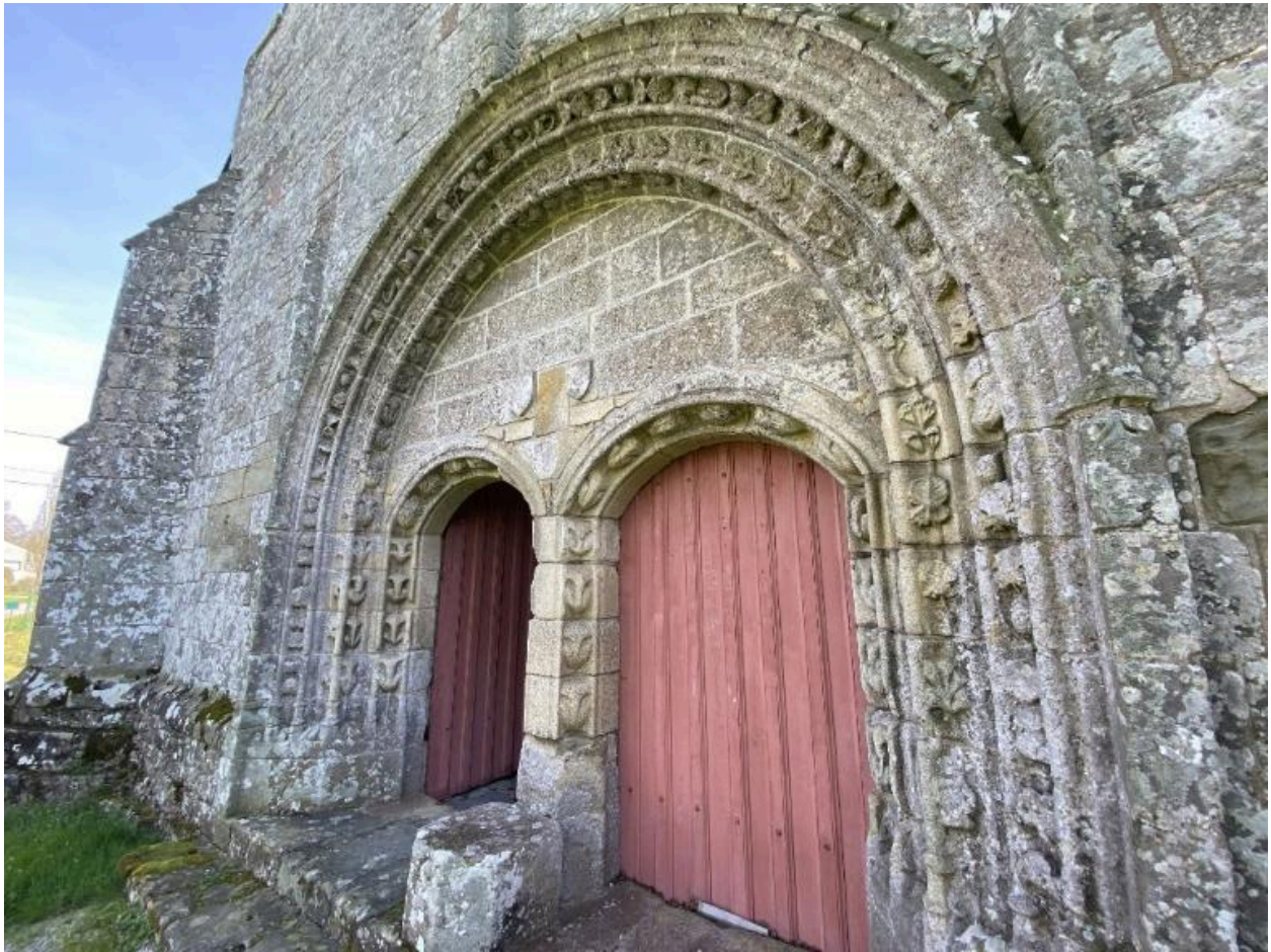
Portail ouest, vue générale
