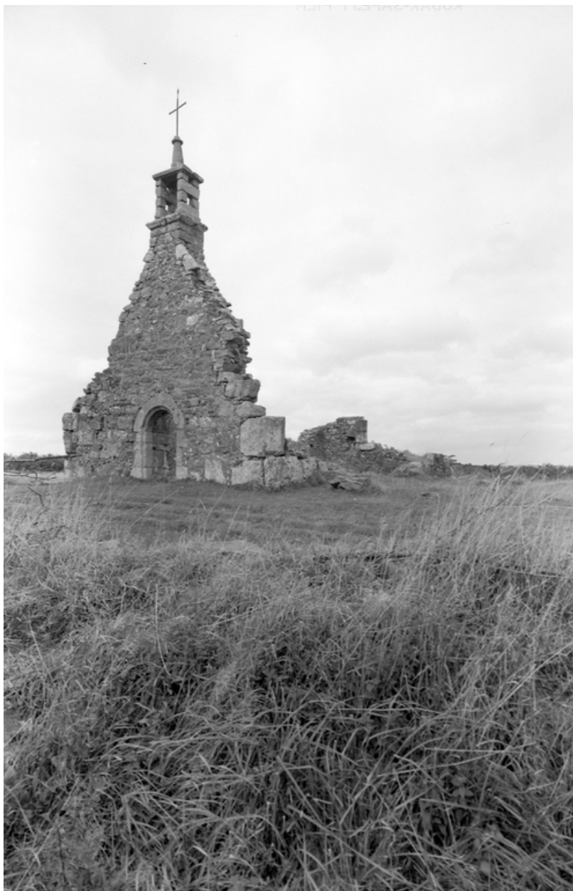
Vue générale du sud ouest
