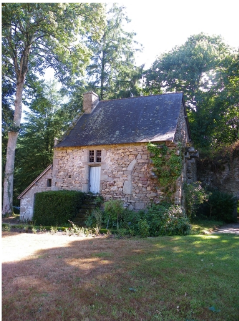
Chambre des Coëtlogon, façade ouest.
