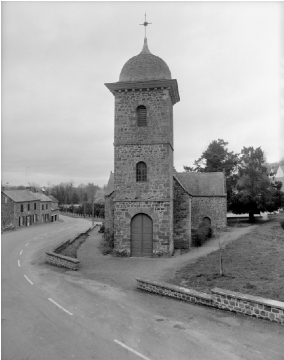
Elévation Ouest : vue générale
