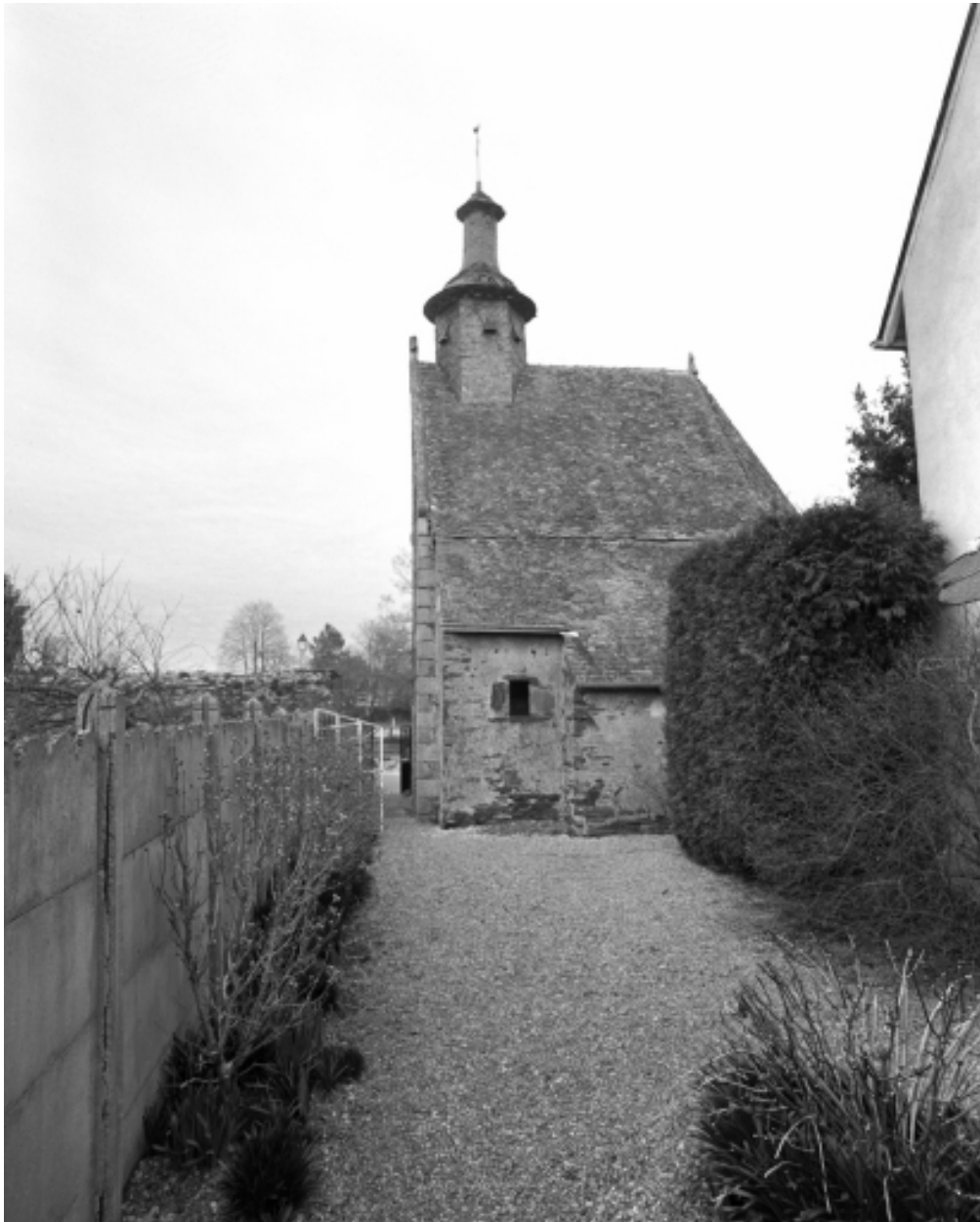
Elévation est ; vue générale
