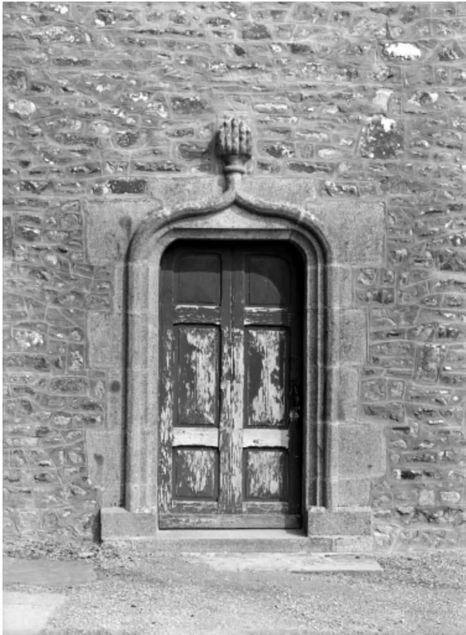
Elévation Sud, bras du transept, porte : vue générale
