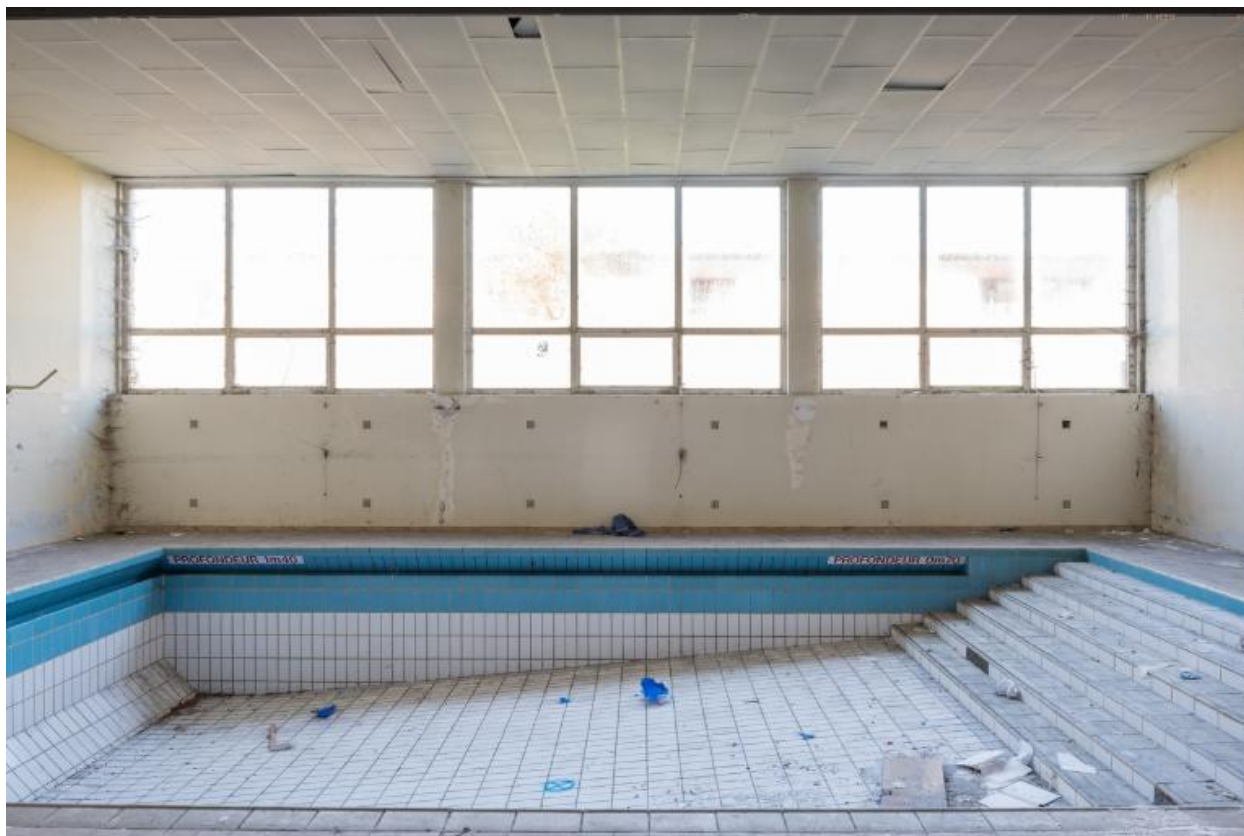
Vue d'ensemble du petit bassin (0,7 à 1,40 m de profondeur). Jean de Jaegher et François Rousseau, architectes, 1968.
