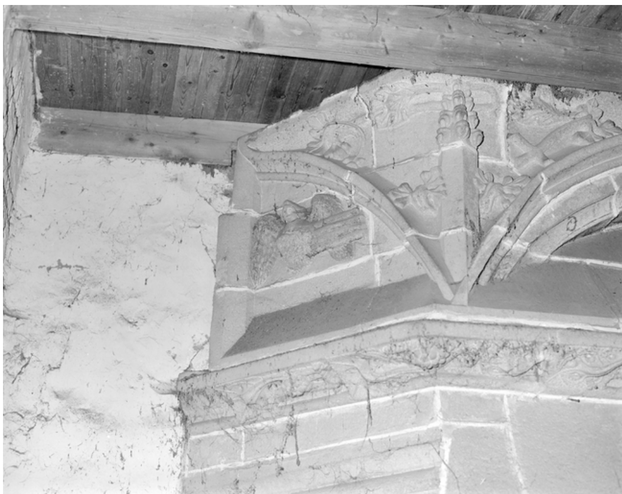
Cheminée, premier étage : détail ange gauche
