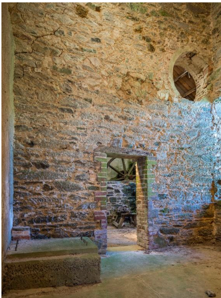
Bâtiment principal. Salle 2. Mur de refend avec porte de communication entre la salle 1 et 2
