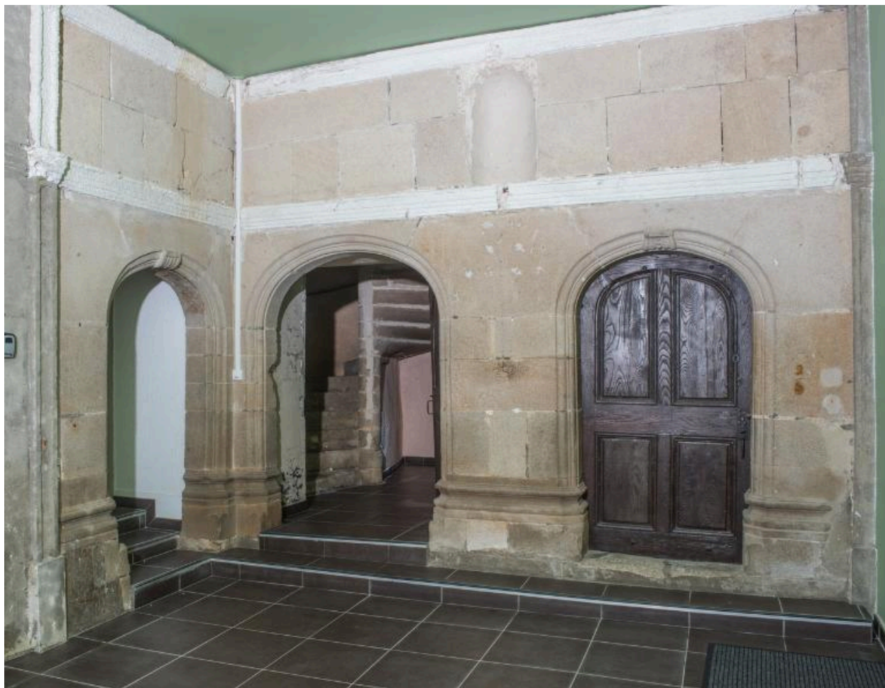
Le vestibule d'entrée
