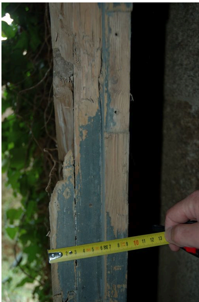
Crozon : vue de l'île des Morts en 2007. Les portes font 9 cm d'épaisseur
