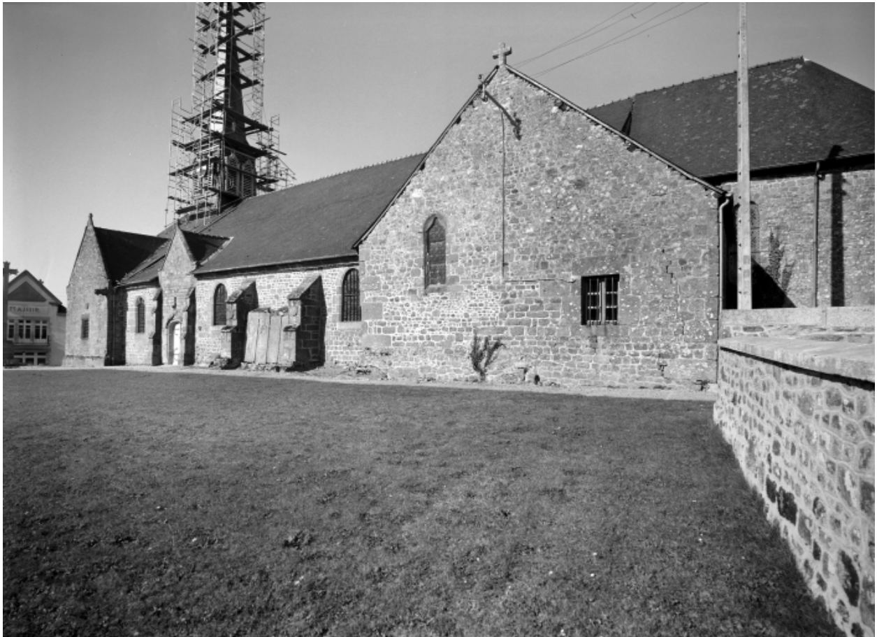
Élévation Sud : vue générale
