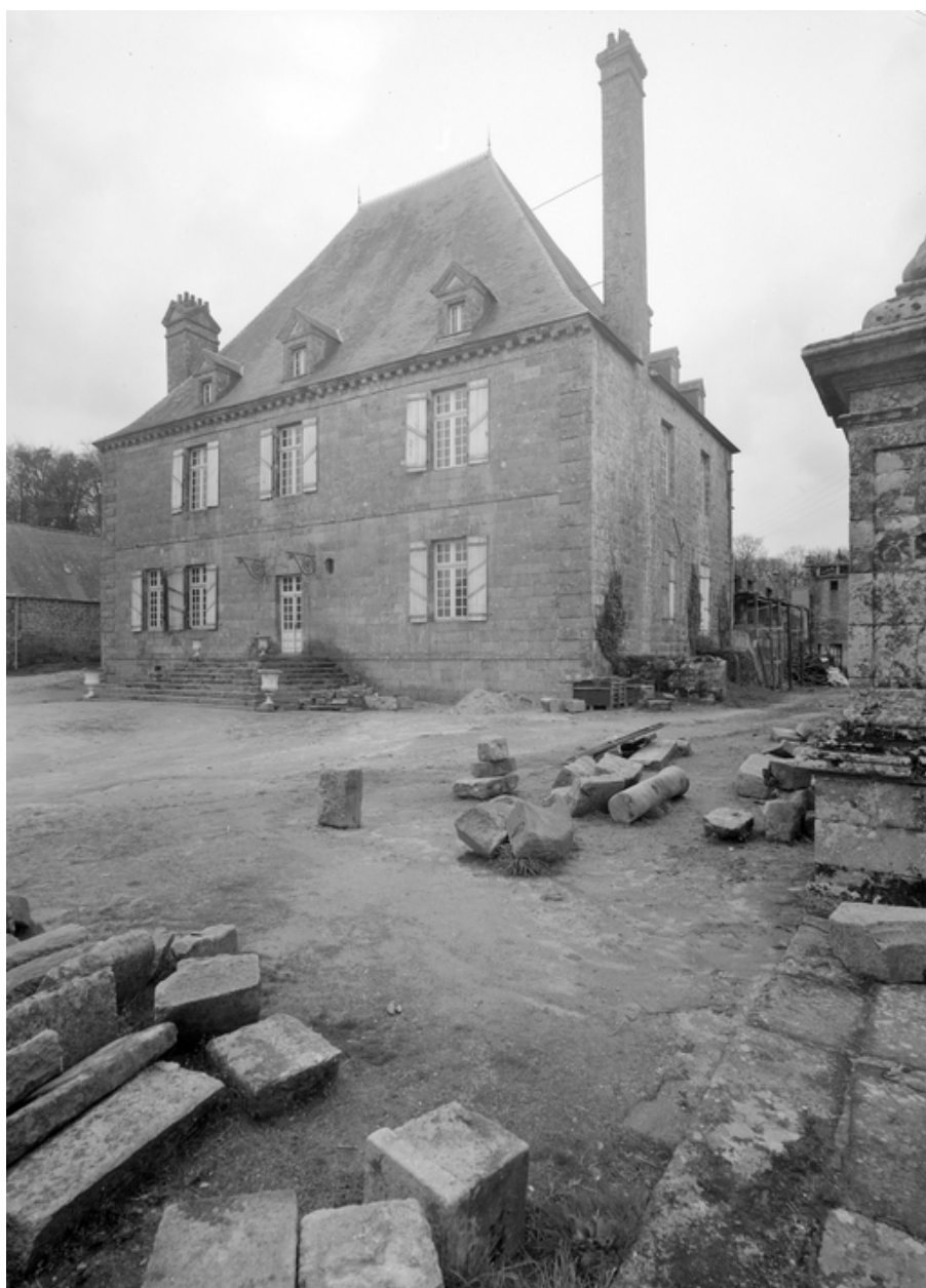
Logis : vue générale prise du sud-est (du jardin)
