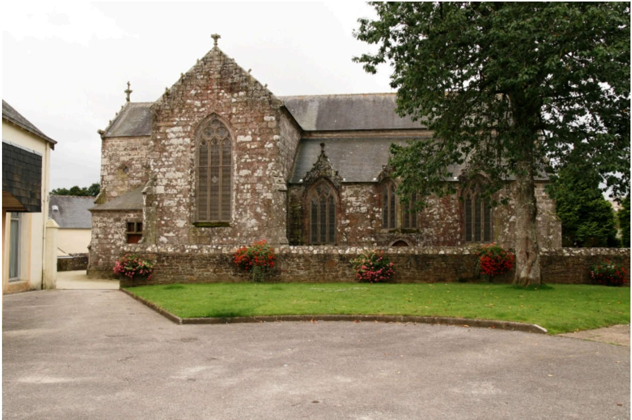
Quéménéven, église paroissiale Saint-Ouen : vue générale nord
