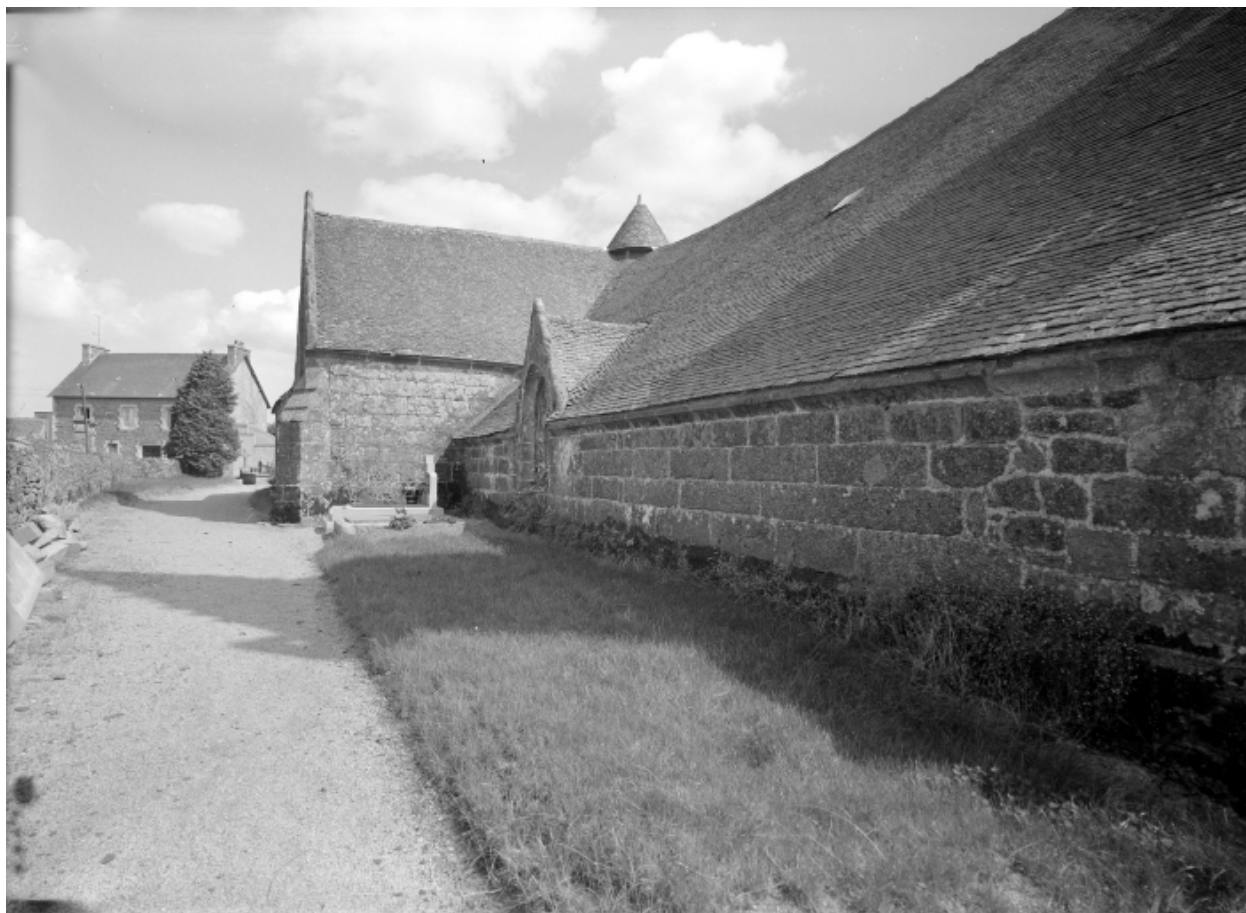
Nef, mur nord pris de l'ouest
