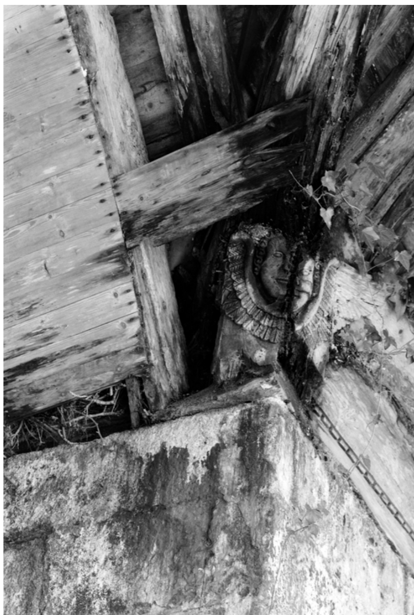
Vue du blochet de l'angle nord-est de la croisée du transept
